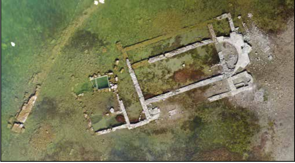
Resim 9: Yapıda geçici koruma ve güçlendirme çalışmaları ile ilgili genel görüntü.
